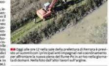
Oggi alle ore 12 nella sede della prefettura di Ferrara è previsto un summit con i prefetti di tutti i dipartimenti per il coordinamento per affrontare la nuova piena del fiume Po in arrivo nella giornata di domani. Nella foto dall'alto i lavori sull'argine.
