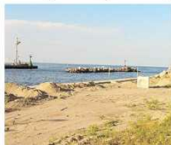
CANTIERE Curnali di sabbia sulla banchina per lo scavo del portocanale.
