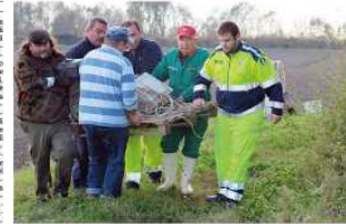
Interventi preventivi di sgombero nel fondovalle e sopra il Ponte di Panaro
