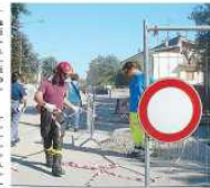
POST TERREMOTO Operai al lavoro
