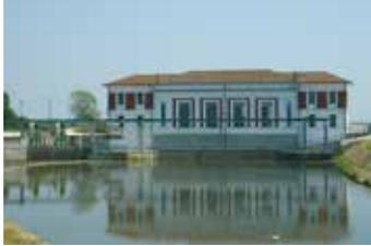
avviata sin dal 1872 con la costruzione dell'idrovoro di BANDO, dotato di pompe centrifughe Gwynne azionate da motori a vapore, al servizio di 7.300 ettari. Successivamente, per problemi strutturali e per il costipamento dei terreni prosciugati, fu costruito un nuovo impianto, ultimato nel 1928. A seguito dei drammatici eventi bellici del 1945, che danneggiarono edifici e macchinari, l'idrovoro fu riportato all'originaria forma e struttura con il progetto datato 16.02.1946 dell'Ing. E. Chailly.
