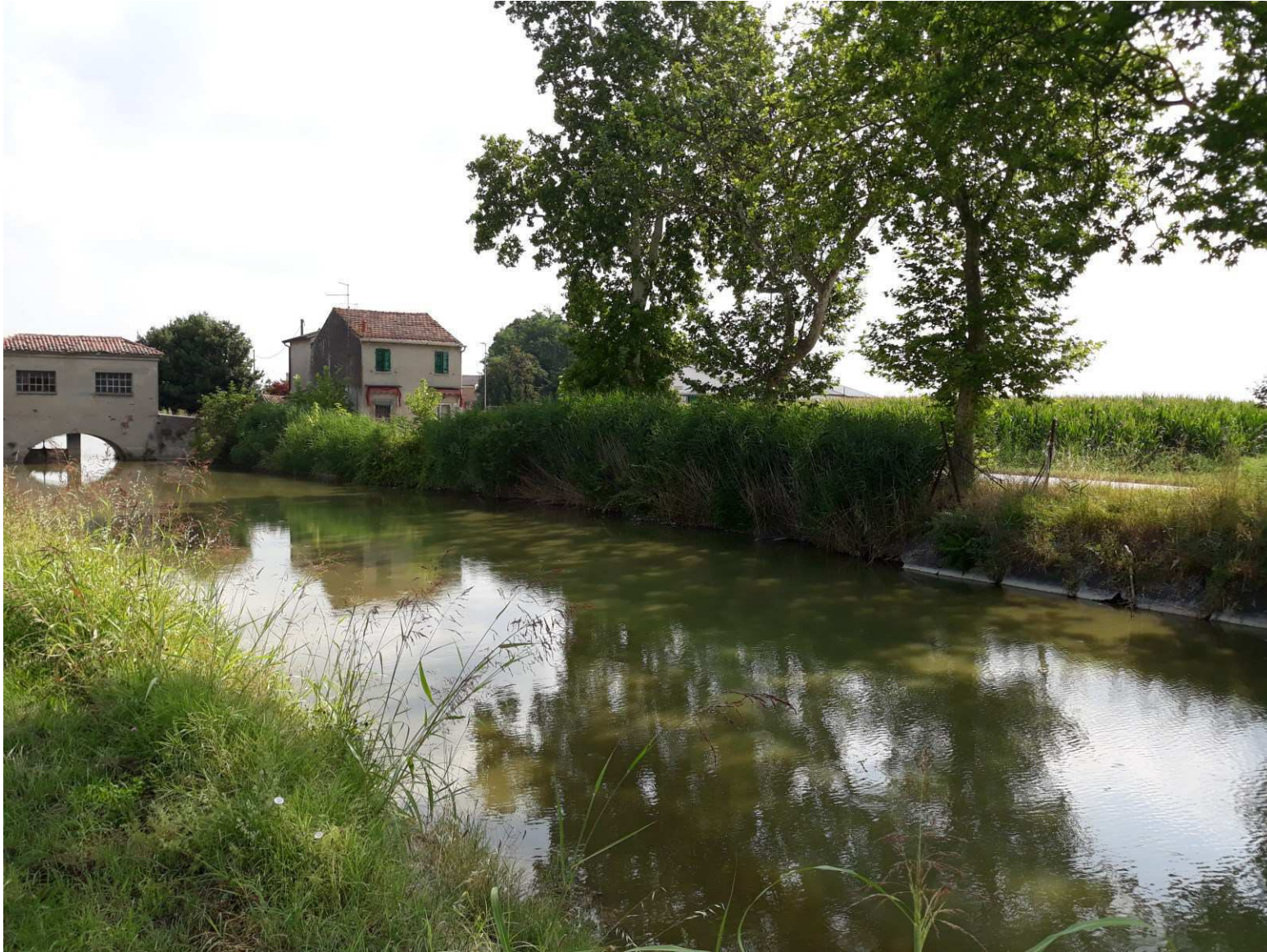
Fig. 1 – STATO ATTUALE AREA INTERVENTO
