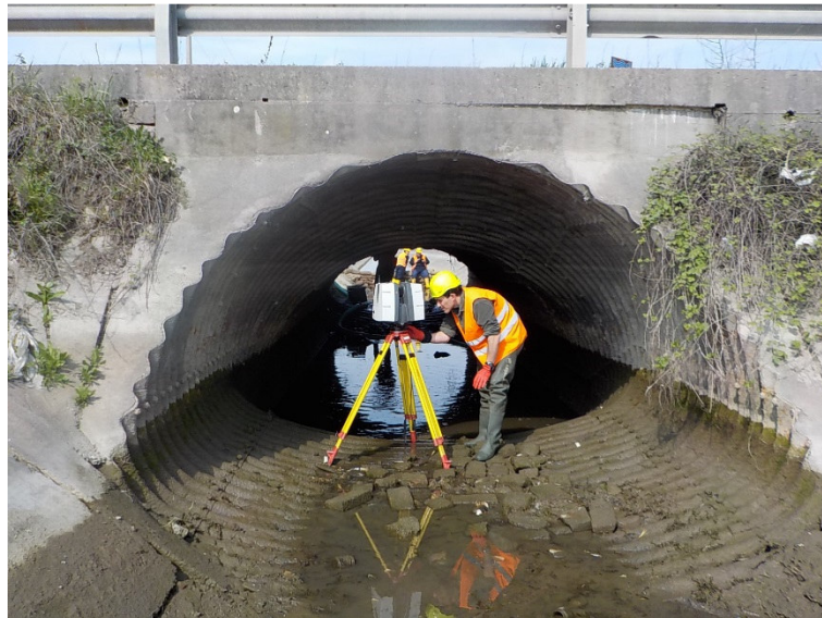
Figura 7: rilievo laser scanning - Tubo Finsider in località Cento
