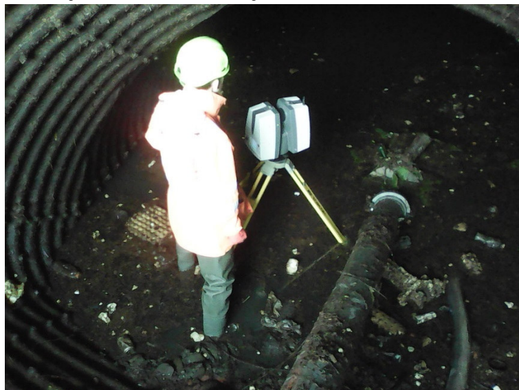
Figura 8: rilievo laser scanning - Tubo Finsider in località Corporeno
