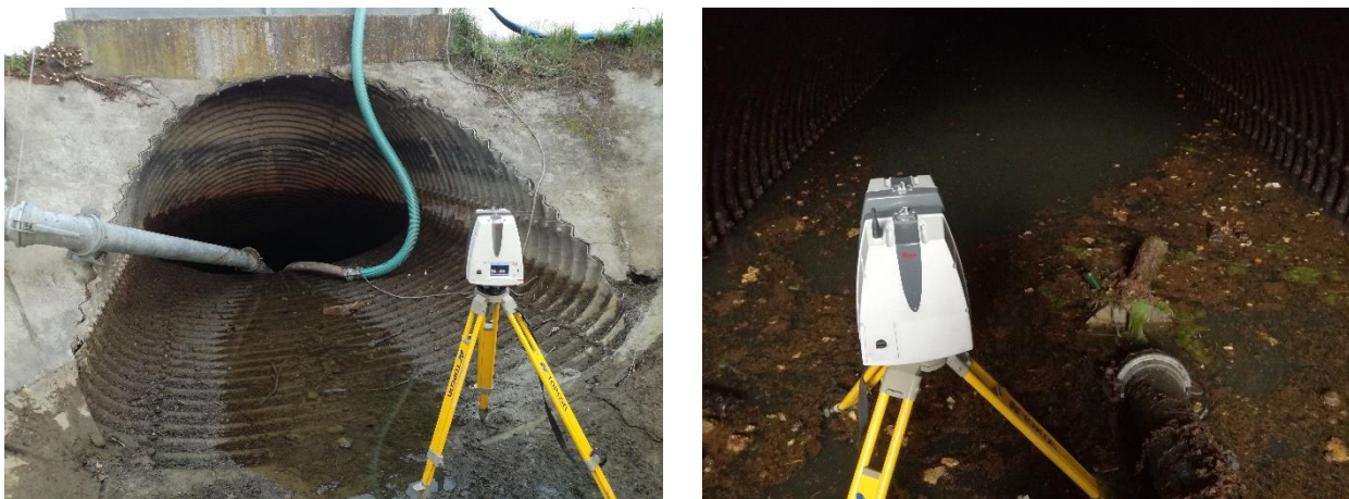
Figura 1 - Esecuzione del rilievo laser scanning
