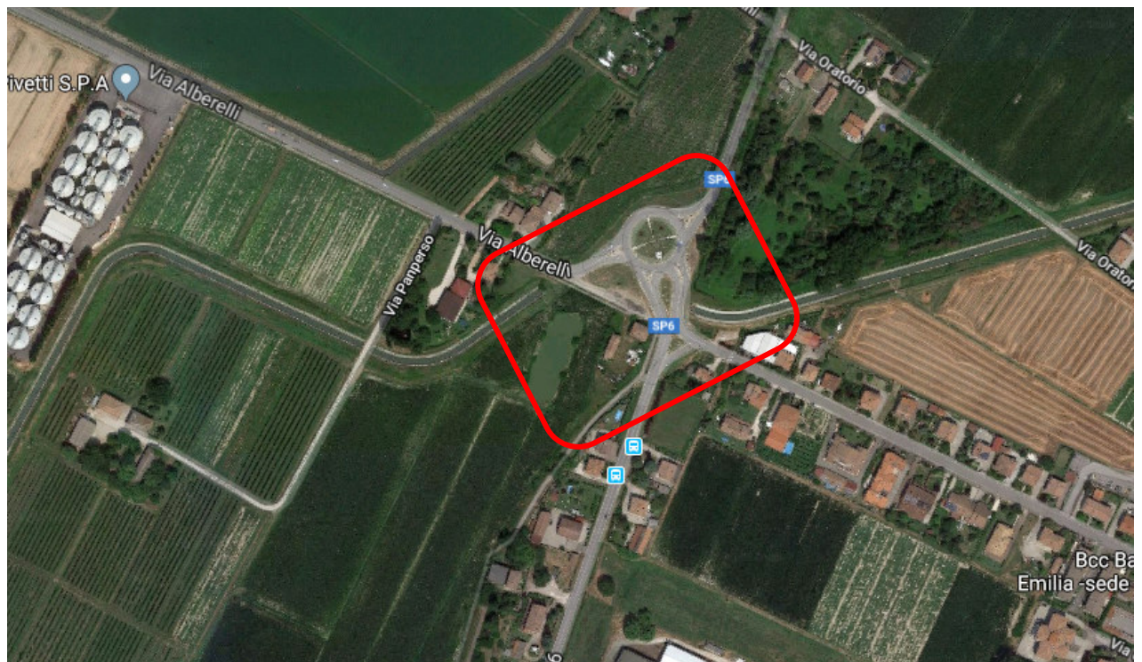
Figura 3: vista aerea – Tubo finsider sito in località Corporeno
