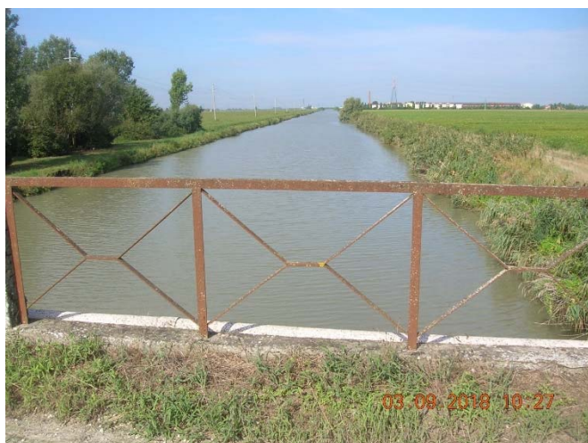
Figura 11. Individuazione del cavo protetto dell'ENEL, interferenza sita in destra idraulica tra le sezioni 52 e 55, foto dal ponte Lamberta.
