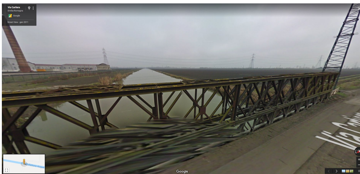
Figura 15. Individuazione del cavo protetto dell'ENEL interferente tra le sezioni 51F e 53 – Foto dal Ponte di via Cartiera verso valle.
