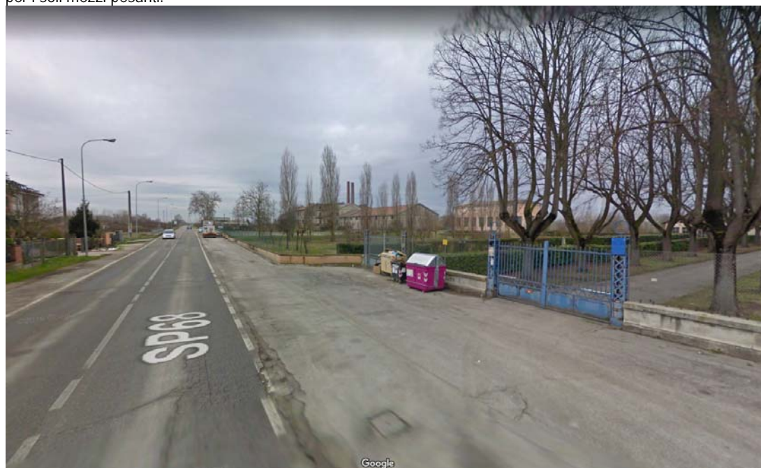
Figura 2. Accesso all'area di accantieramento – Cancelli grigio ed azzurro per i mezzi pesanti.
