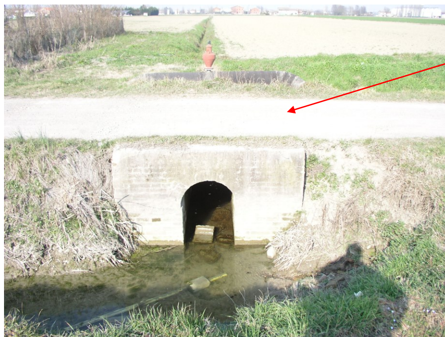
Ponte via Chiarelli
