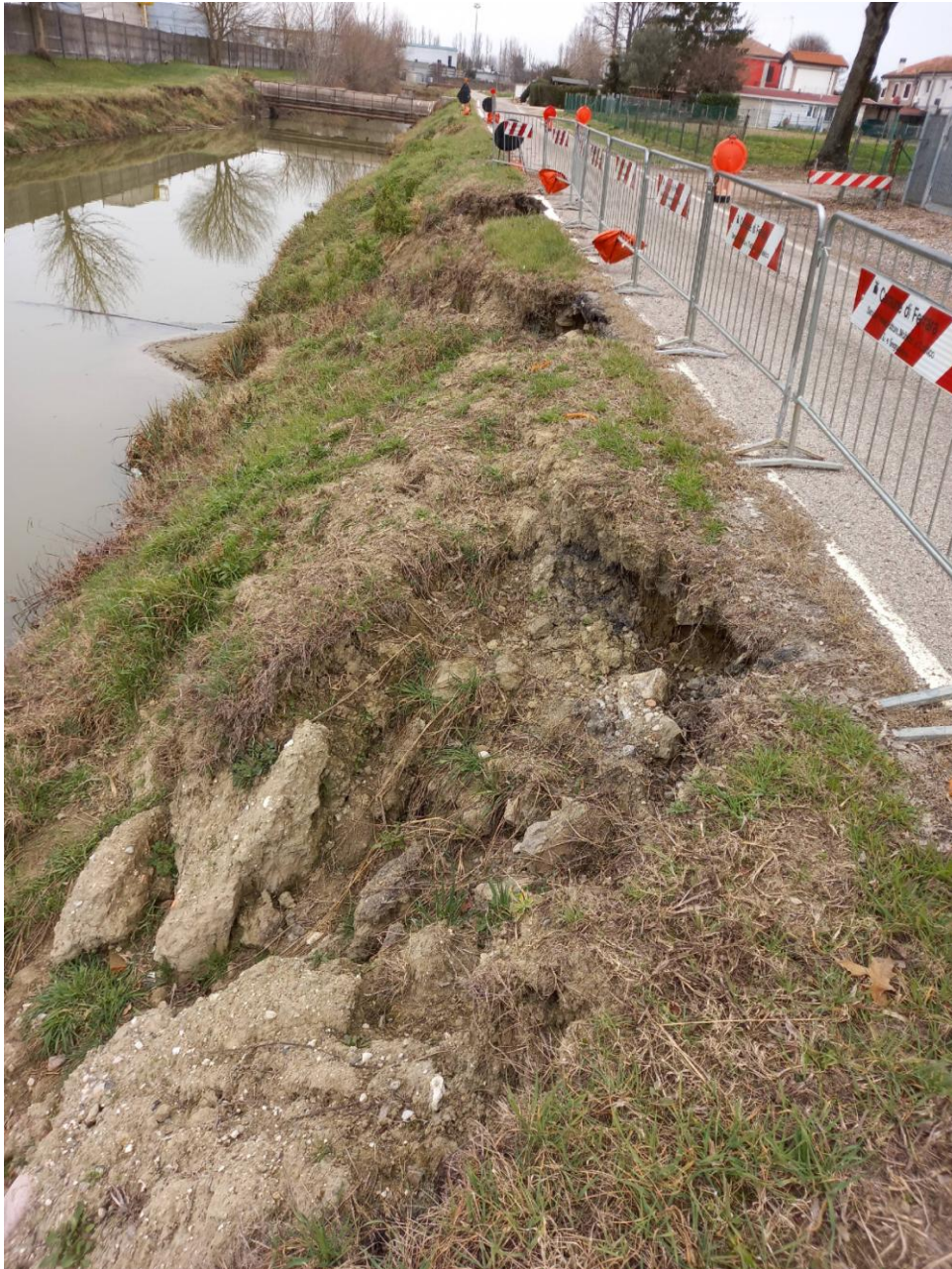
FIGURA - 2 – PARTICOLARE DEL CEDIMENTO SPONDALE
