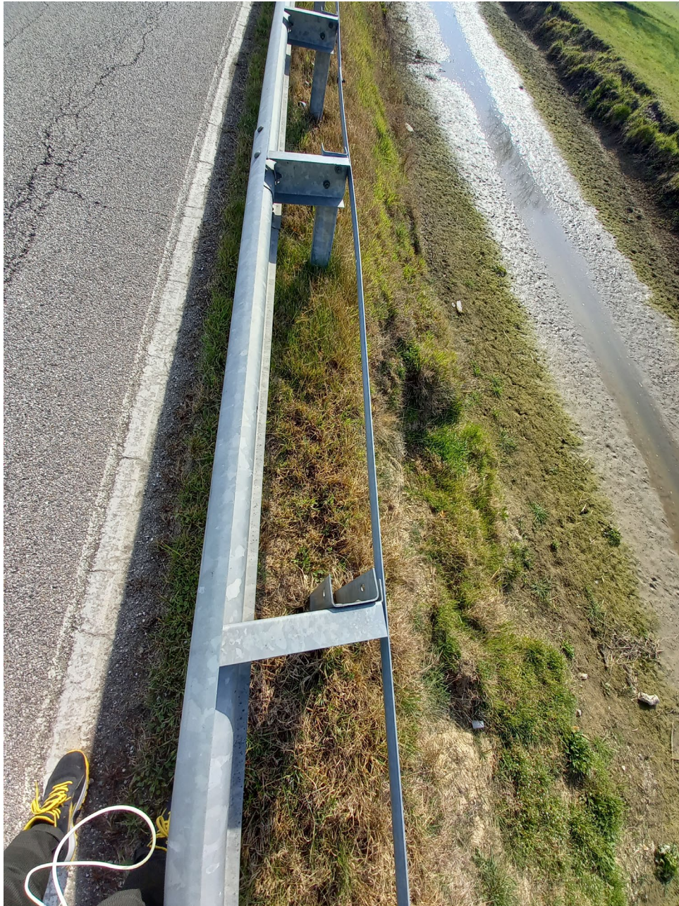
FIGURA - 3 – PARTICOLARE DEL CEDIMENTO SPONDALE
