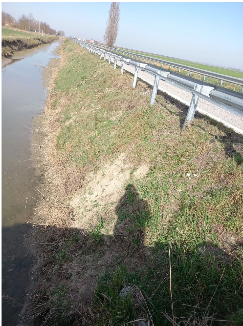
FIGURA - 2 – PARTICOLARE DEL CEDIMENTO SPONDALE
