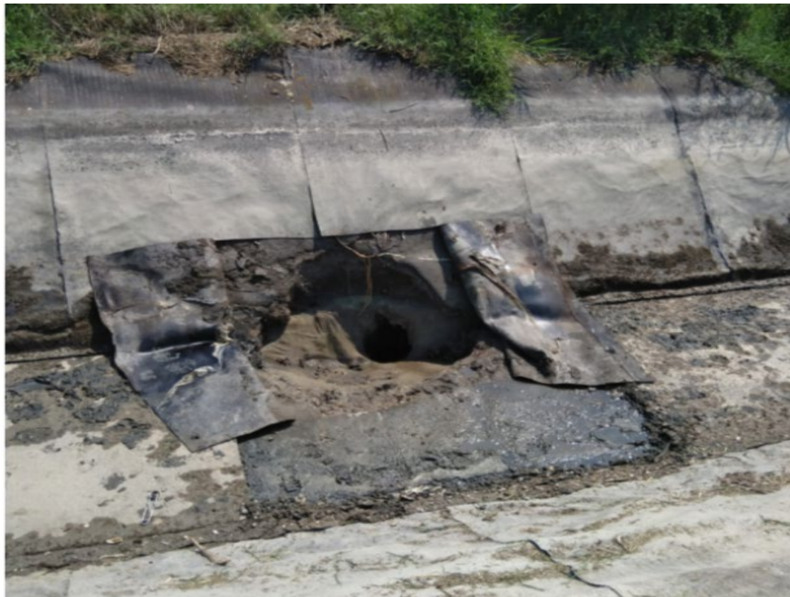
Figura 4. Rottura arginale esposta.
