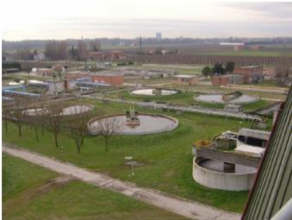
Fig. 4 - Depuratore di Ferrara
