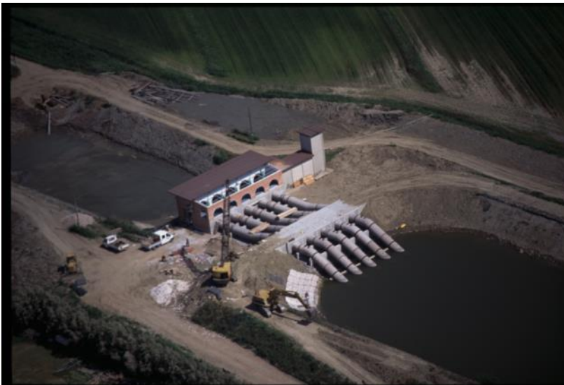
Impianto Idrovo Romanina, maggio 2003.
