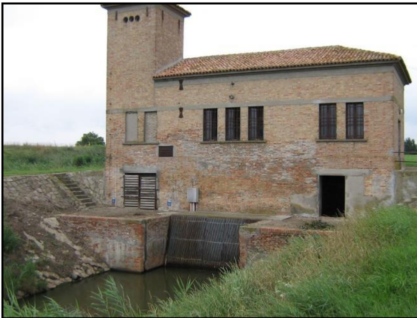
Veduta da monte dell'Impianto Idrovorio Staffano (priv.).
