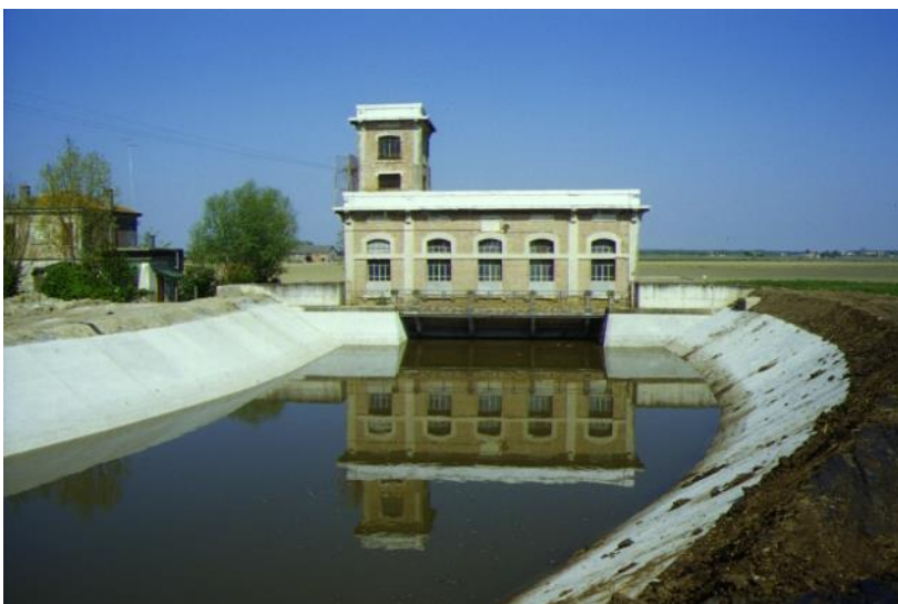
Figura a sinistra: Impianto Idrovaro Salghèa.
