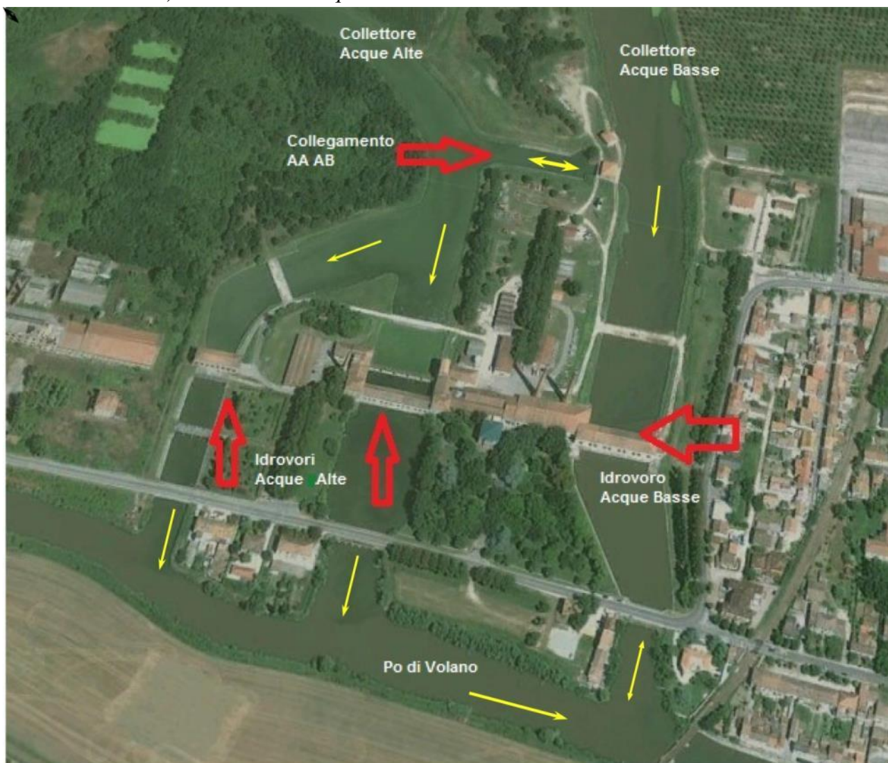
Impianti idrovori di Codigoro Acque Alte e Acque Basse.
