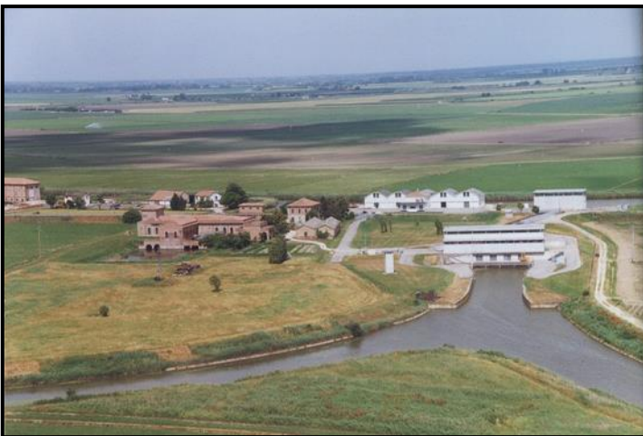
Veduta aerea dell'Impianto Idrovoro Marozzo, visto da sudovest verso nord-est.
