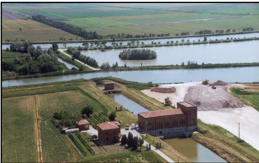
Impianto Idrovoro San Zagno- fotocattata da nord verso sud. Sullo sfondo le vallette di Ostellato
