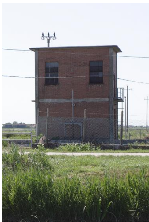
Nella figura a sinistra, l' Impianto Idrovorio Demetrio
